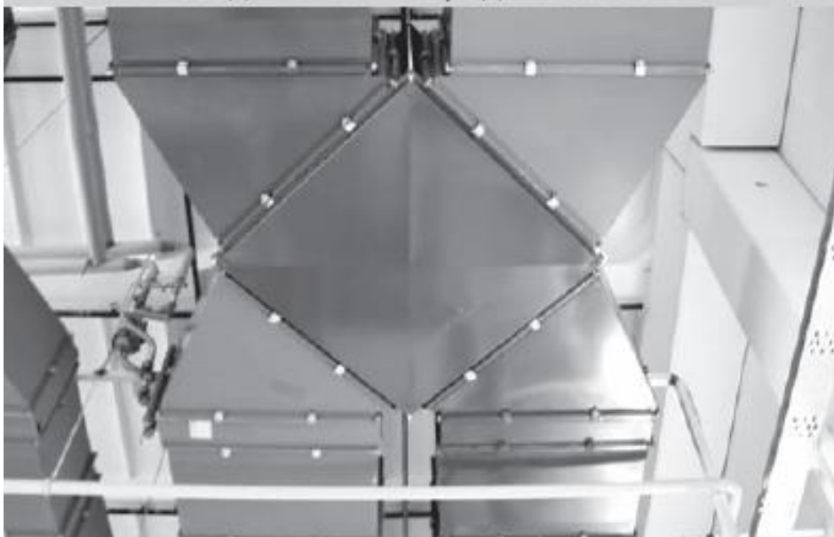
Рис. 13 – соединение посередине скобой
